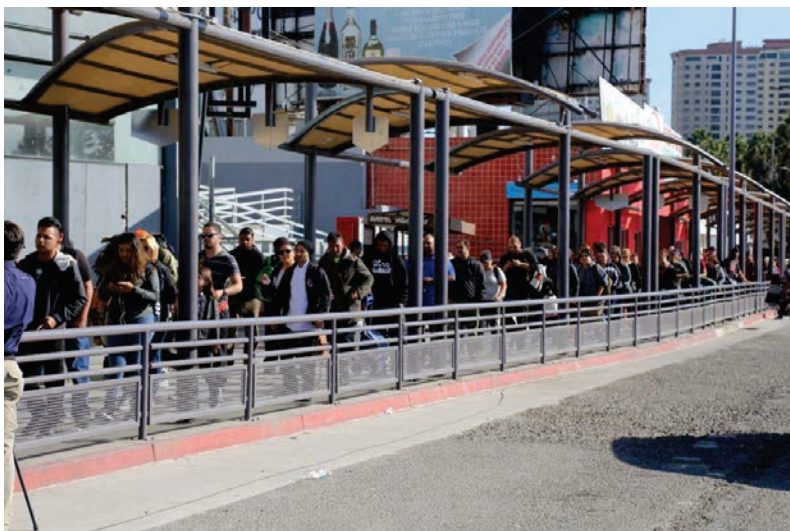
Fotografía 2. Puente internacional Tijuana
