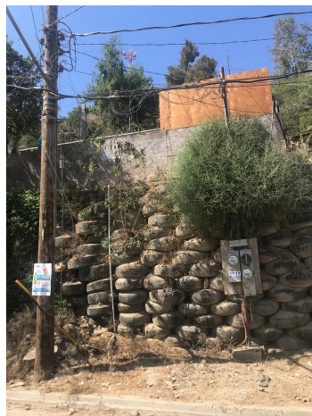
Figura 3.2. Construcción con llantas usadas. Fuente: Fotografía tomada por la autora (2021).
