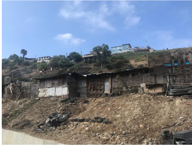
Figura 3.3. Casas en la orilla de la canalización.
