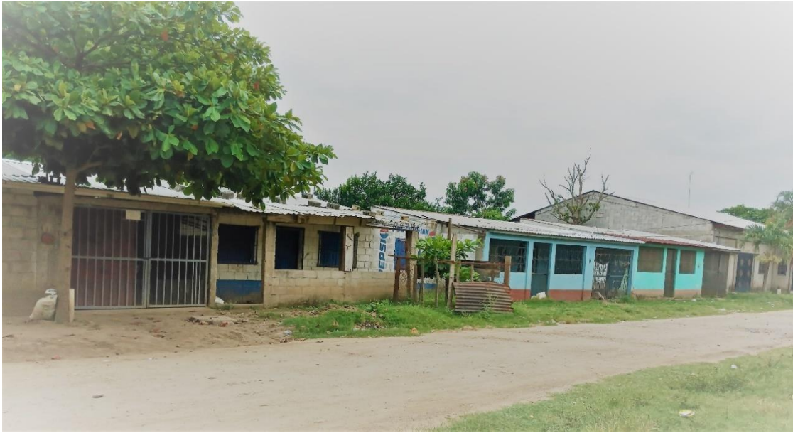
Vista de viviendas Colonia Vida Nueva.
