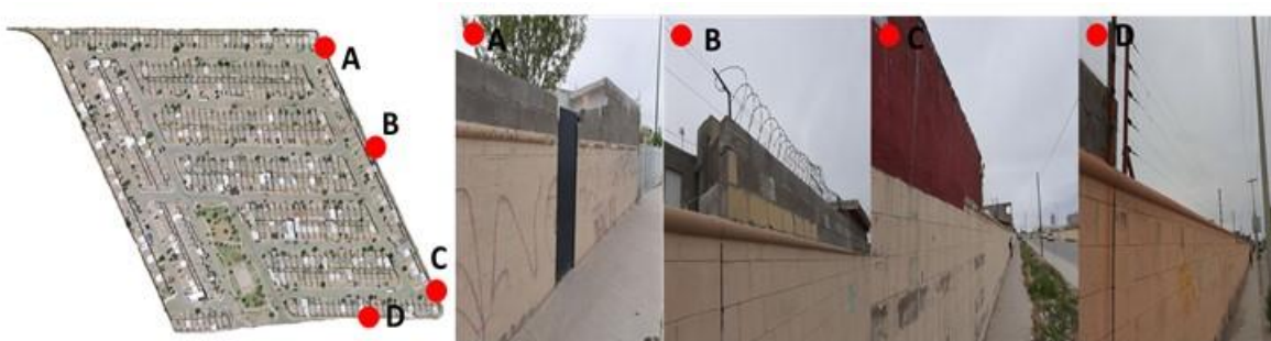
Imagen 4.10 Muro perimetral de Cerrada del Parque V
