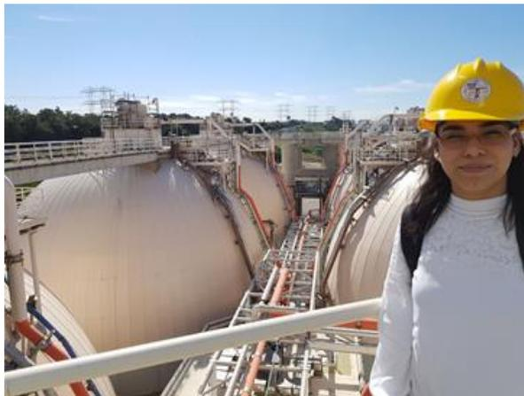
Tanques esféricos de almacenamiento de biogás
