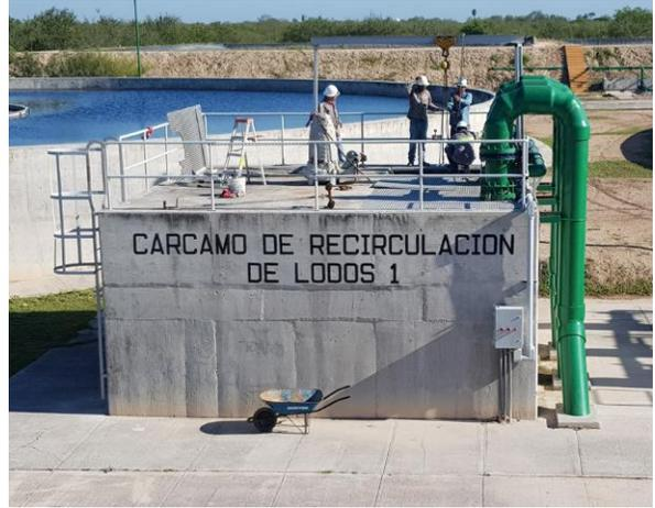
Cárcamo de recirculación de lodos del clarificador No.1
