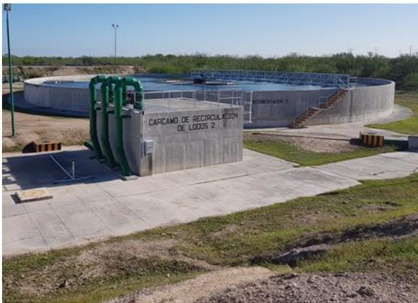
Cárcamo de recirculación de lodos del clarificador No.2
