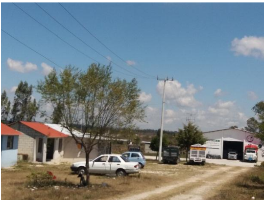
Foto 5.2: Infraestructura de la organización La Trinitaria, Chiapas, 2018 Fotografía: Teresa González
