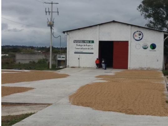
Foto 5.1: Bodega de acopio de café La Trinitaria, Chiapas, 2018 Fotografía: Teresa González
