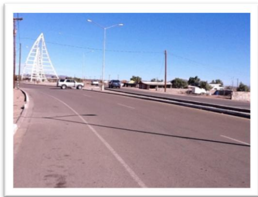
Foto 5.27. Vista del Boulevard los Ángeles, vialidad principal de BLA
