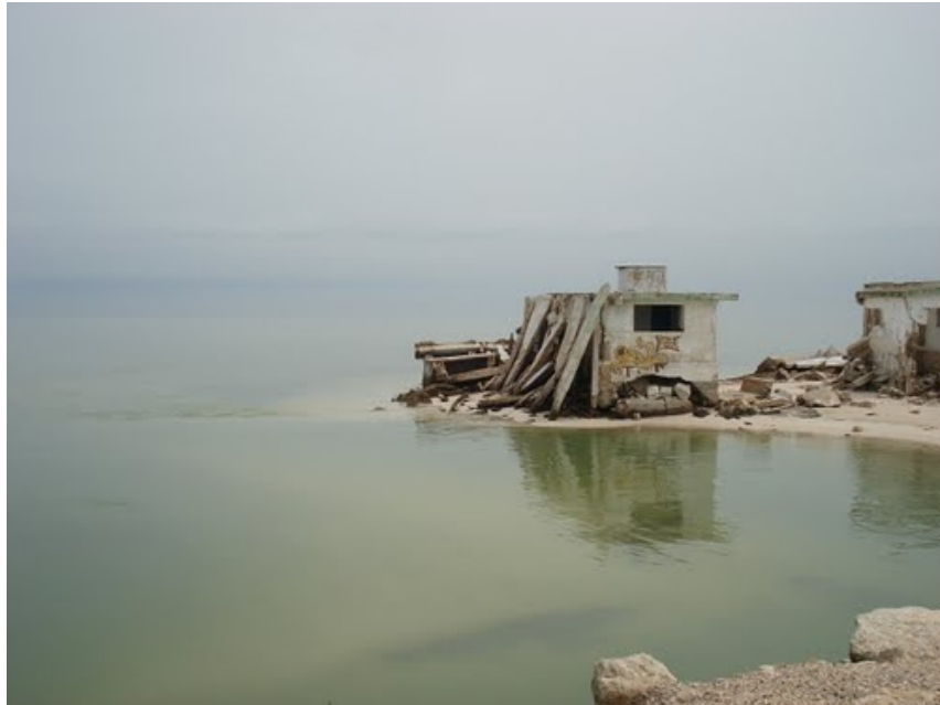
Fotografía 10 Vivienda destruida completamente en el puerto de Chabihau
