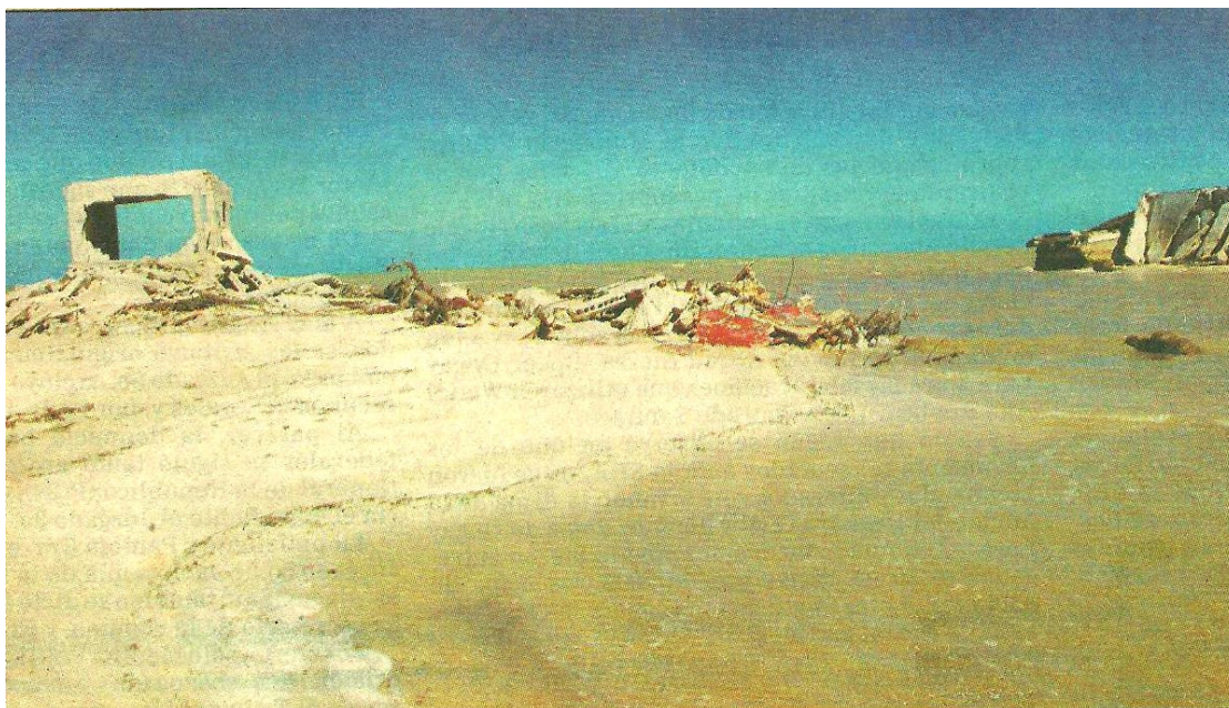
Imagen 7. Vivienda completamente destruida por Isidoro
