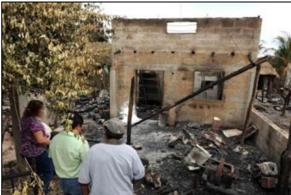
Fotografía 4.6. Vivienda siniestrada en la reubicación de El Escondido
