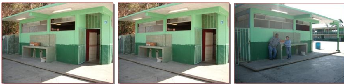
Foto 4.7: Baños I, Baños II y Personal de limpieza, ER.
