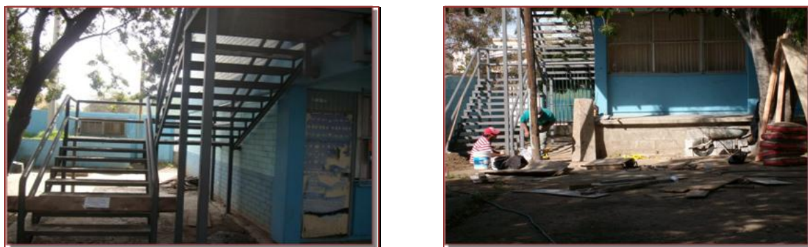
Foto 4.1: Escaleras I y II, EC.
