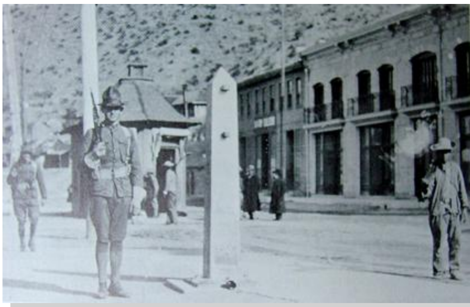
Fotografía 2.1. Frontera, ambos Nogales.
