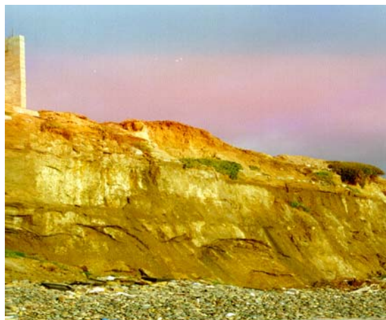
Foto 5.35. Erosión del cantil
