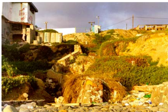
Foto 5.3. Perfil de relleno
